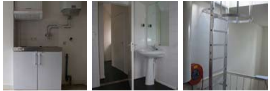
Foto III: Foto's van standaard keuken en badkamer en een voorbeeld van de brandweereisen waaraan een Studio in Groningen pand voldoet.
